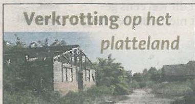
Verkrotting op het platteland Oude lege stallen en hokken en verpauperde boerderijen zijn een toenemend probleem op het platteland in Zuidoost-Brabant. Het ED besteedt hier in een aantal verhalen aandacht aan.
